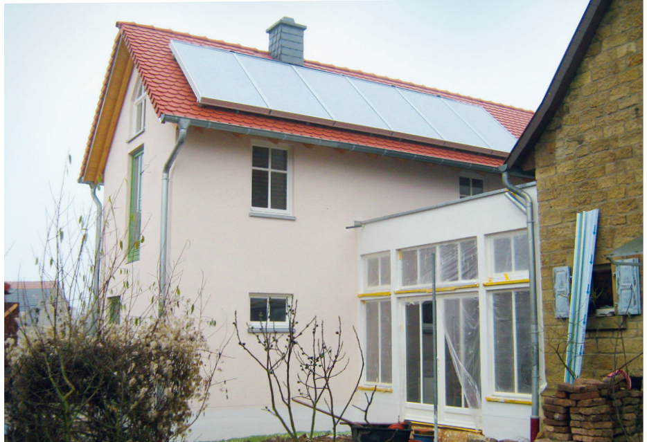
Energetische Sanierung eines kleineren Wohngebäudes und Anbau eines Wintergartens / Odernheim
